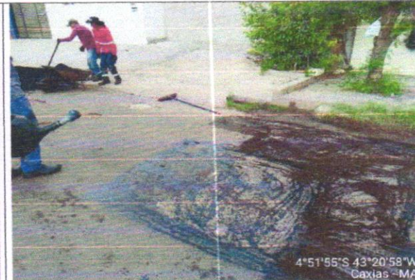
EXECUÇÃO DE TAPA BURACOS
