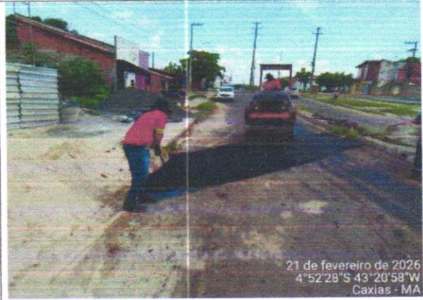
EXECUÇÃO DE TAPA BURACOS
