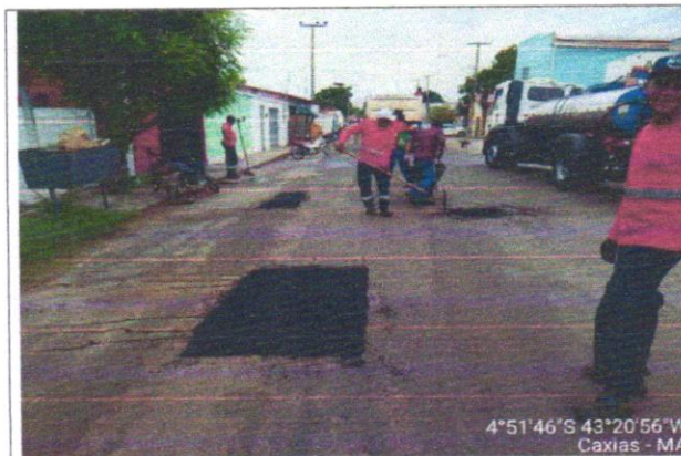
EXECUÇÃO DE TAPA BURACOS
