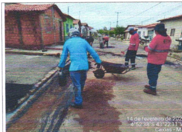
EXECUÇÃO DE TAPA BURACOS
