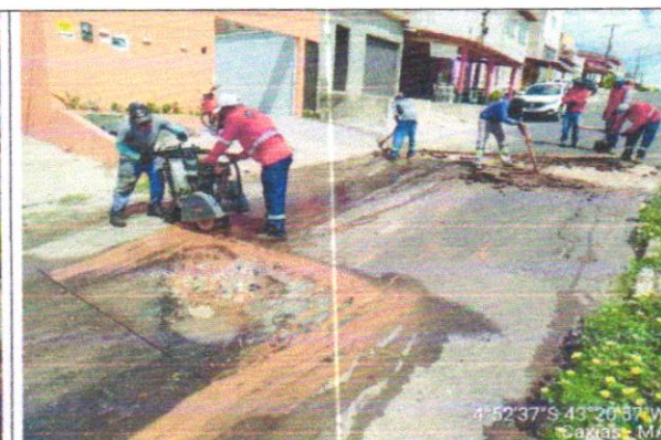
EXECUÇÃO DE TAPA BURACOS
