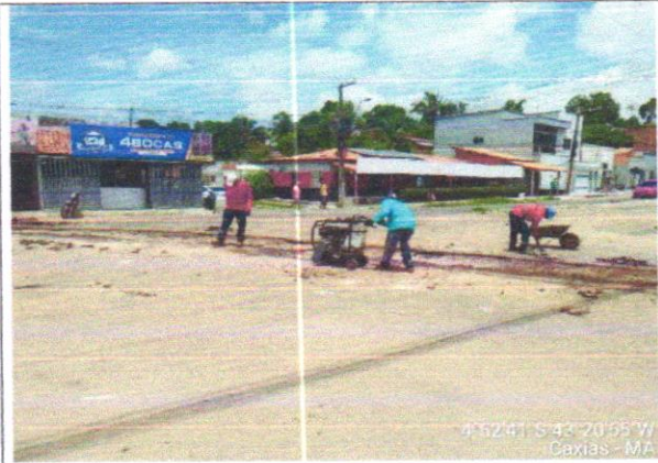
EXECUÇÃO DE TAPA BURACOS
