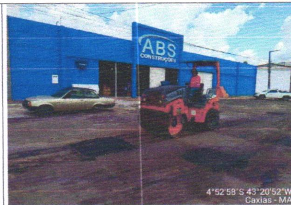
EXECUÇÃO DE TAPA BURACOS
