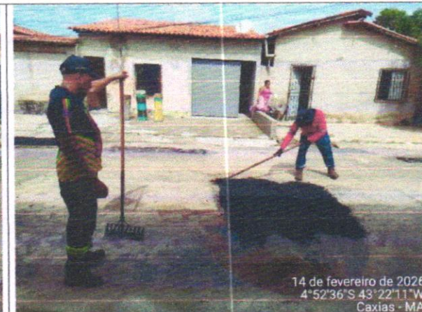
EXECUÇÃO DE TAPA BURACOS
