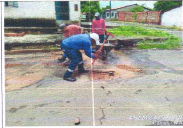
EXECUÇÃO DE TAPA BURACOS
