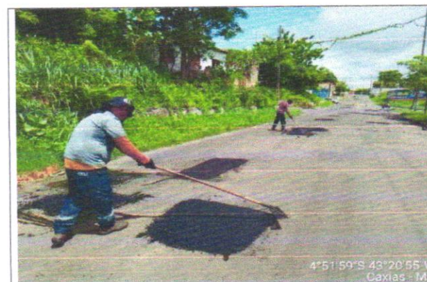
EXECUÇÃO DE TAPA BURACOS
