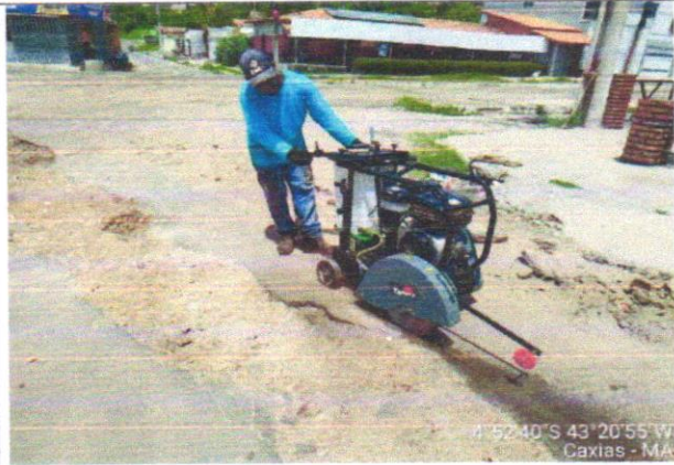
EXECUÇÃO DE TAPA BURACOS
