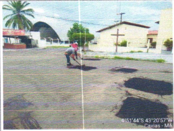
EXECUÇÃO DE TAPA BURACOS
