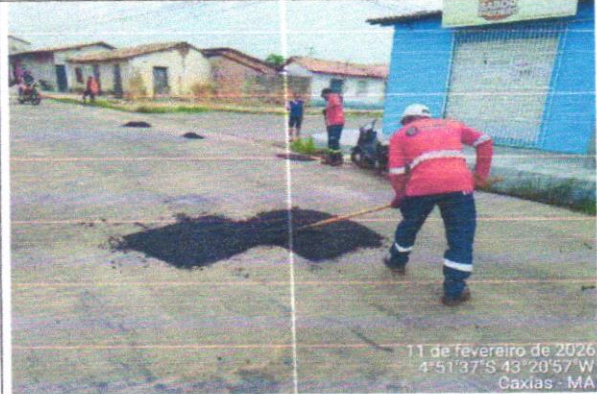
EXECUÇÃO DE TAPA BURACOS
