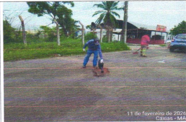
EXECUÇÃO DE TAPA BURACOS
