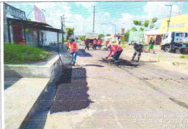
EXECUÇÃO DE TAPA BURACOS
