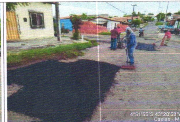
EXECUÇÃO DE TAPA BURACOS
