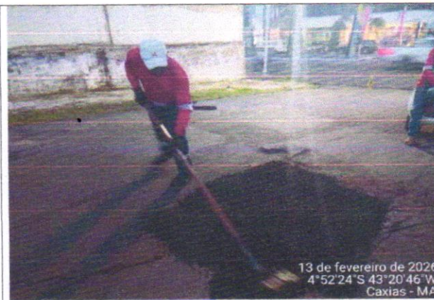
EXECUÇÃO DE TAPA BURACOS
