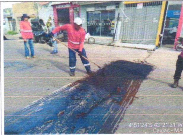
EXECUÇÃO DE TAPA BURACOS
