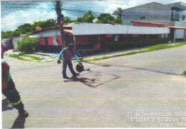
EXECUÇÃO DE TAPA BURACOS
