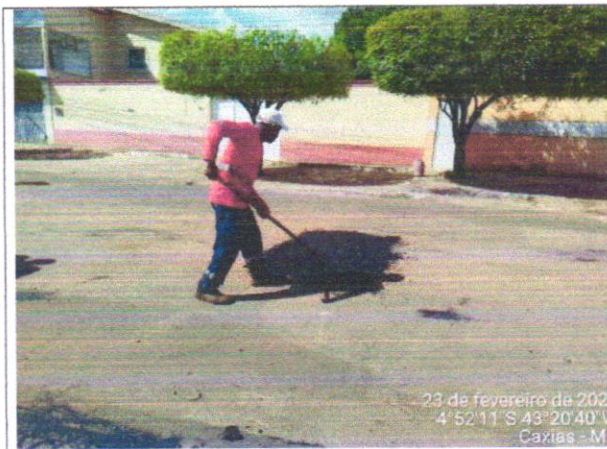
EXECUÇÃO DE TAPA BURACOS
