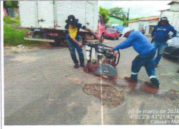
ESQUADREJAMENTO E LIMPEZA
