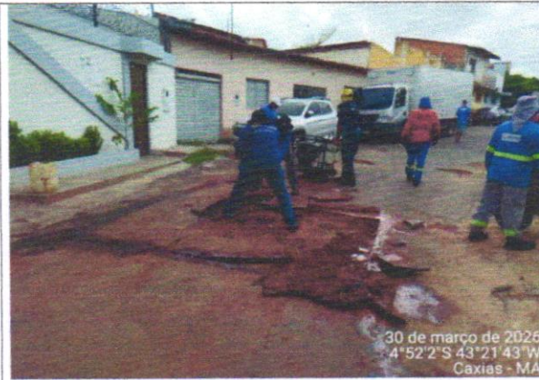
ESQUADREJAMENTO E LIMPEZA
