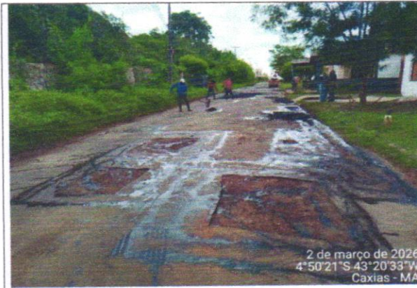
APLICAÇÃO DE PINTURA DE LIGAÇÃO
