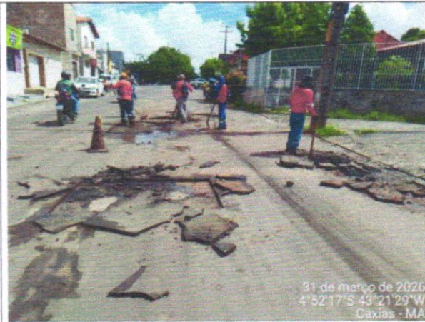
ESQUADREJAMENTO E LIMPEZA
