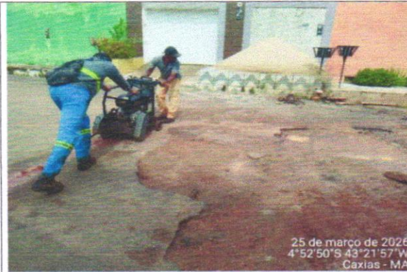
ESQUADREJAMENTO E LIMPEZA
