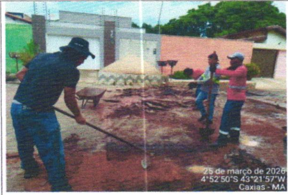
ESQUADREJAMENTO E LIMPEZA
