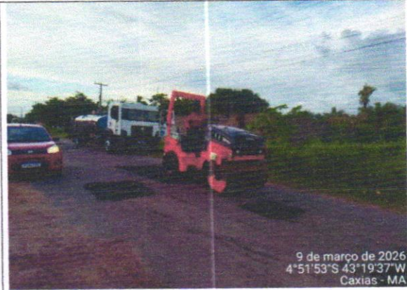
ESQUADREJAMENTO E LIMPEZA
