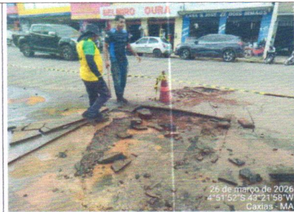
ESQUADREJAMENTO E LIMPEZA
