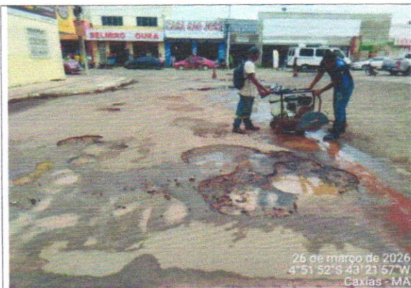
ESQUADREJAMENTO E LIMPEZA
