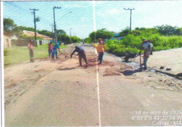
ESQUADREJAMENTO E LIMPEZA
