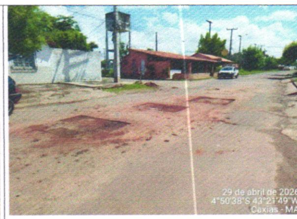
ESQUADREJAMENTO E LIMPEZA
