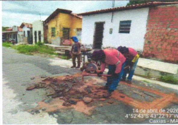
ESQUADREJAMENTO E LIMPEZA
