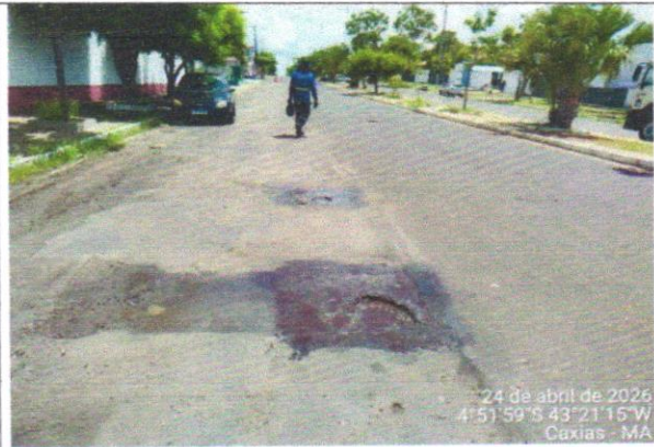
ESQUADREJAMENTO E LIMPEZA
