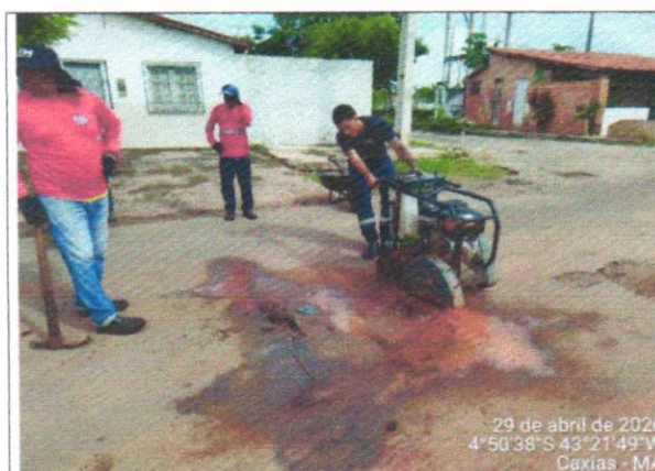
ESQUADREJAMENTO E LIMPEZA
