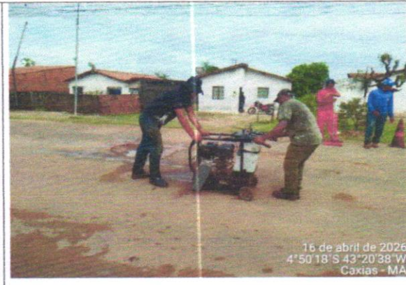
ESQUADREJAMENTO E LIMPEZA
