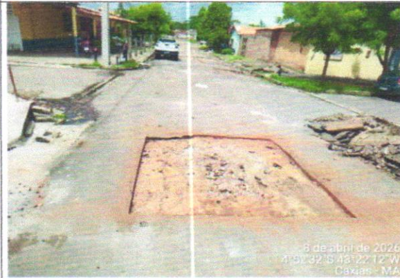
ESQUADREJAMENTO E LIMPEZA
